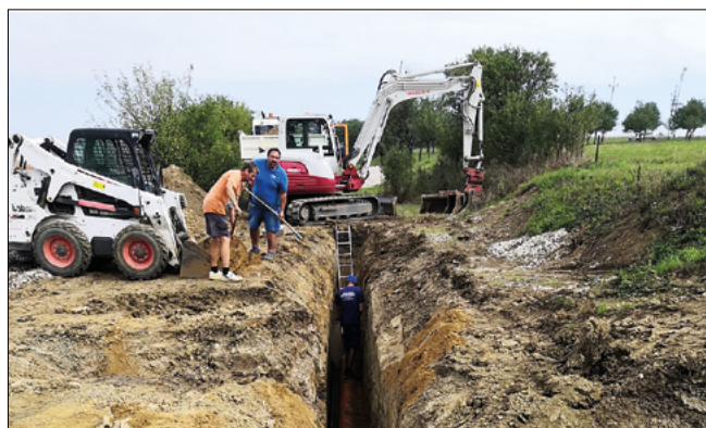
Budování inženýrských sítí v části Škubance.
